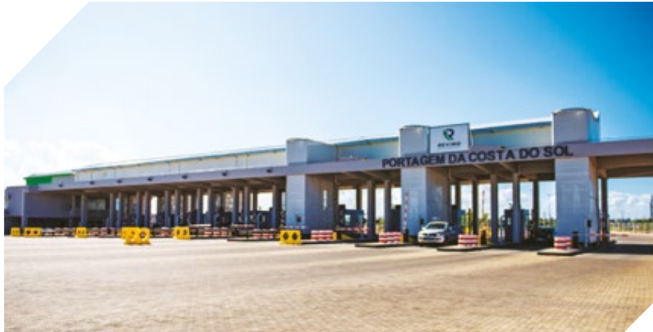
Início da cobrança nas portagens da Circular Start of Toll charge in the ring road
